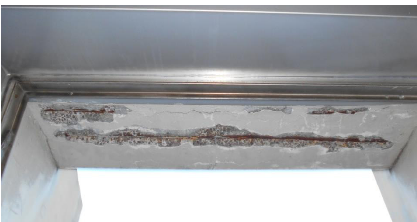
Esempio di carbonatazione esterna
