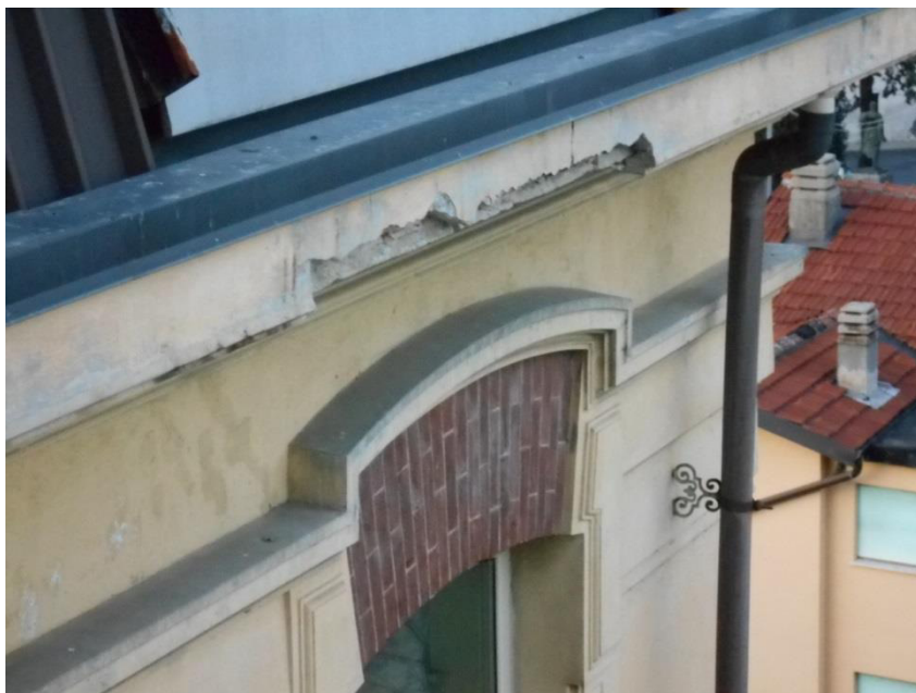
Tratto di cornicione esterno deteriorato
