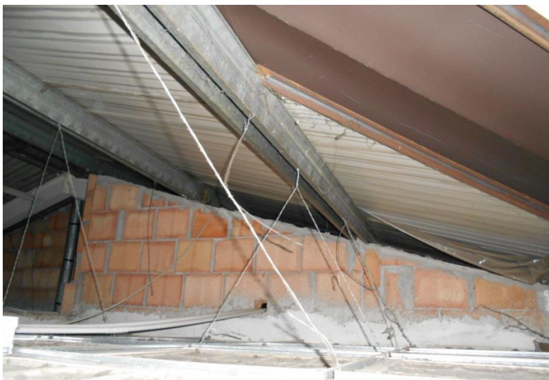
Sistema di sospensione e sostegno della struttura del controsoffitto
