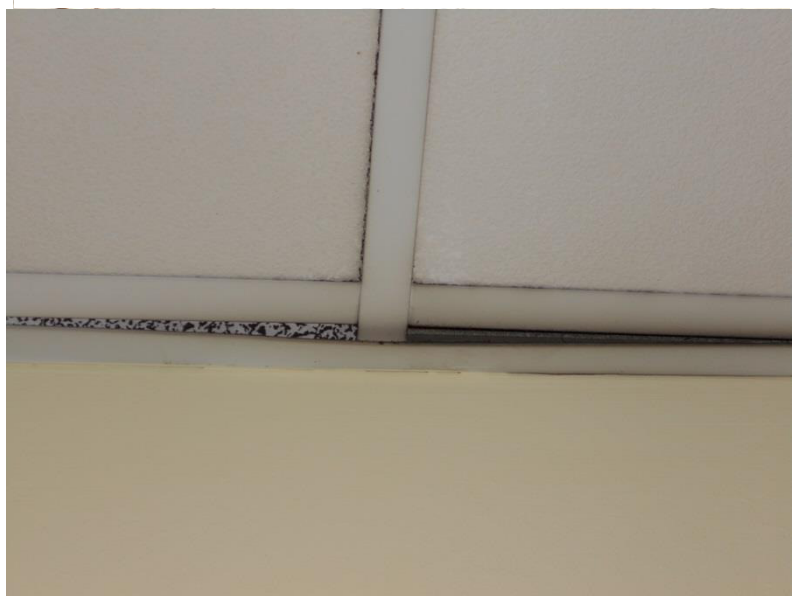
Tratti di deformazione della struttura del controsoffitto
