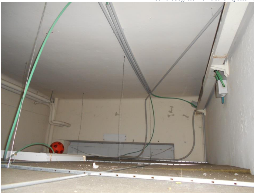
Sistemi di ancoraggio, sospensione e struttura del controsoffitto
